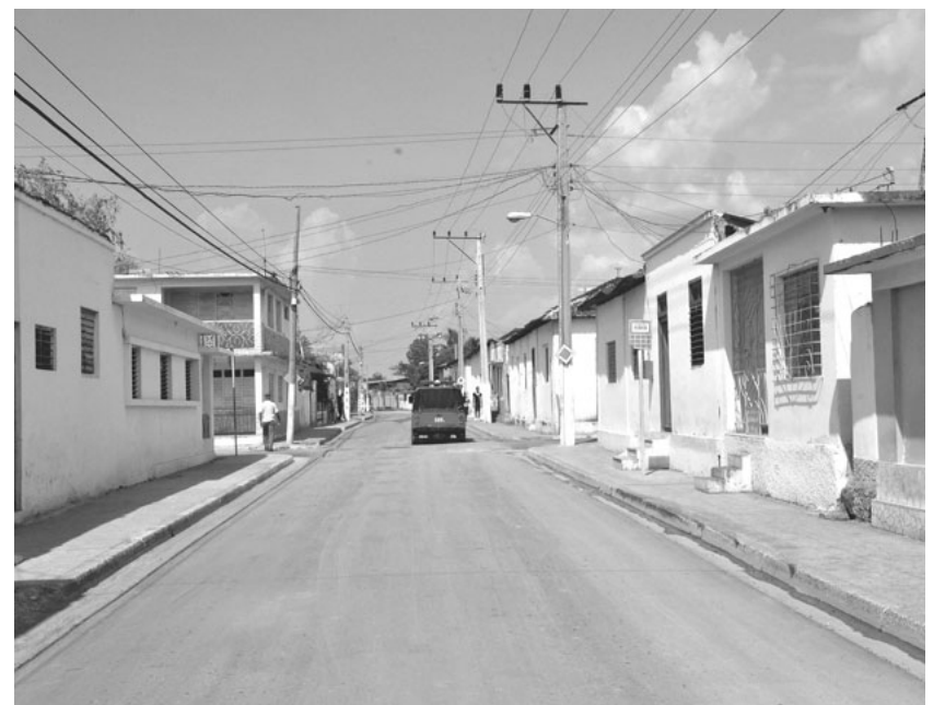
La reconstrucción de esta vía urbana, en Campechuela, cambió para bien el rostro de esa ciudad costera
