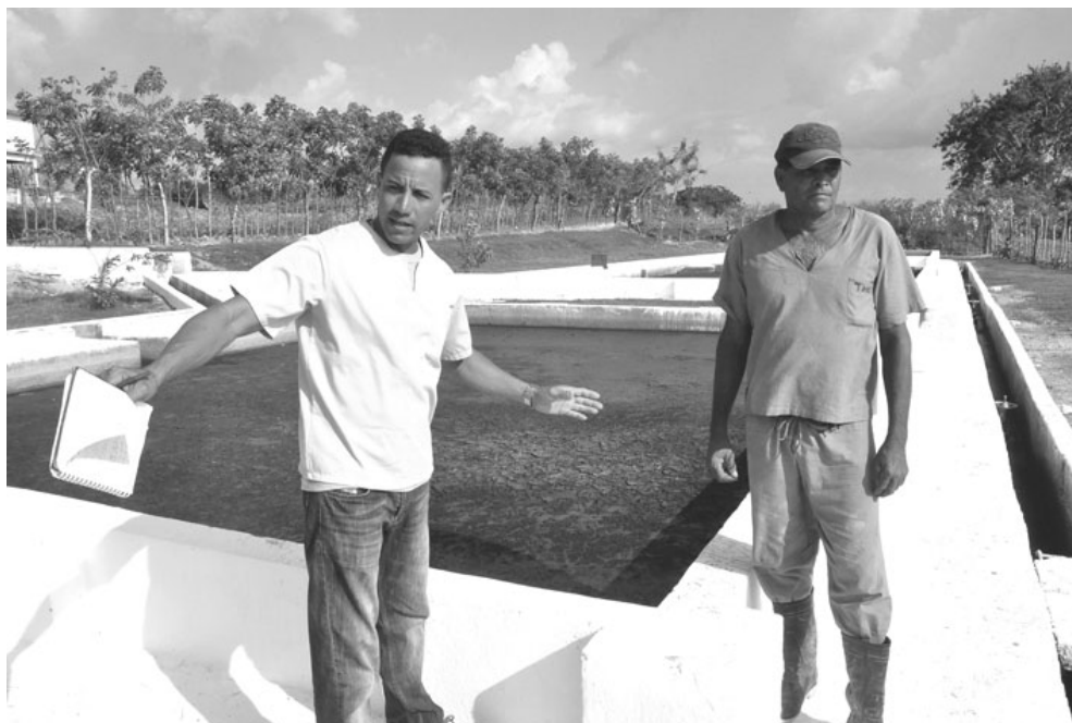
Sistema de tratamiento de residuales de la UEB porcina La Demajagua
