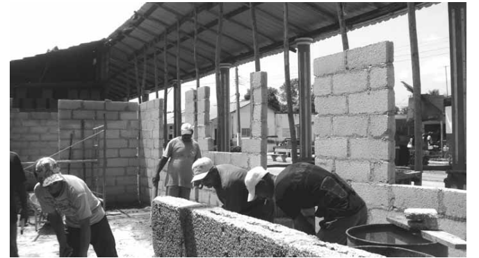
A un lado de la avenida General Jesús Rabí se construye la dulcería de Veguitas
