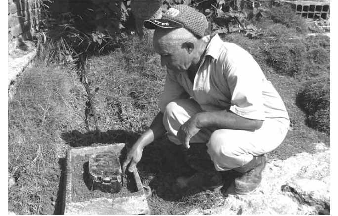
Un plomero coloca un metrocontador para una vivienda, en el reparto Carlos Coello
