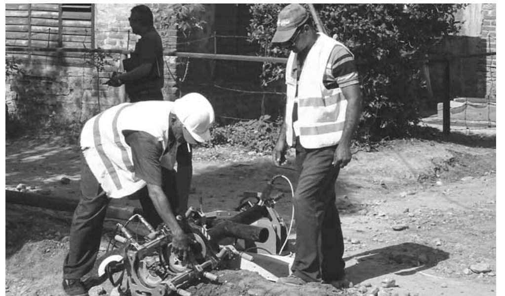
En la zona norte de Bayamo se rehabilitan las redes de suministro de agua y construye un sistema de acueducto que beneficiará a unas 100 mil personas
