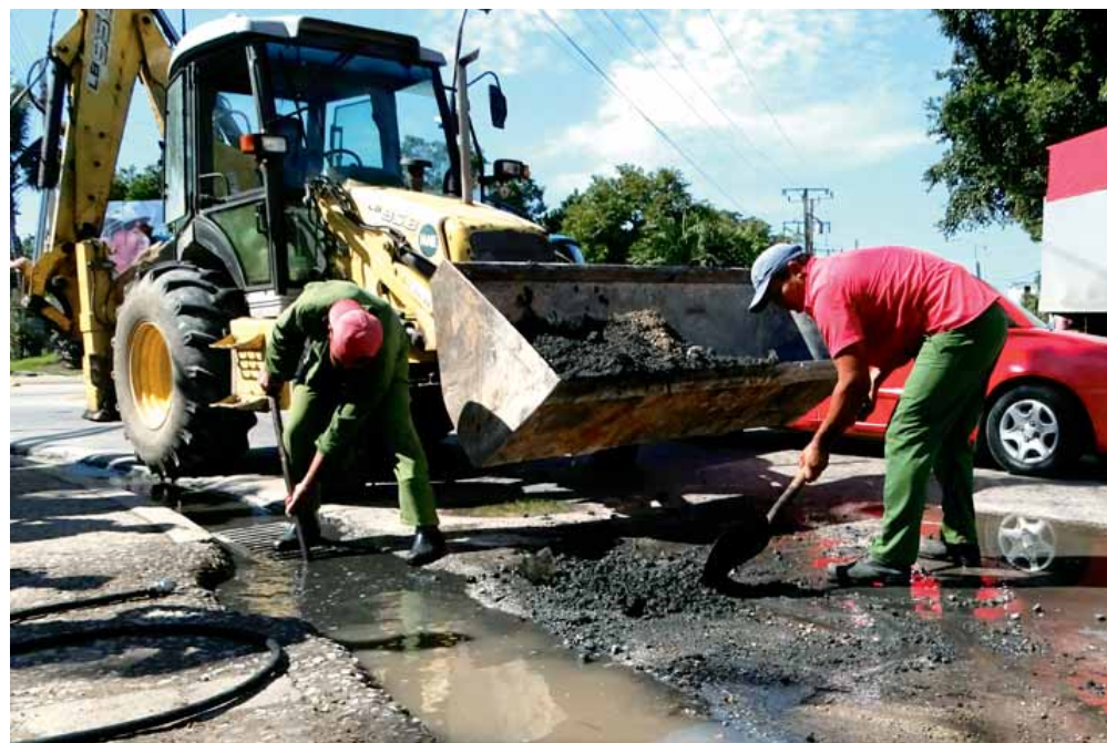
Erradicación de salideros y limpieza de alcantarillado en Manzanillo
