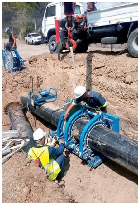
**Conexión de la conductora de 500 mm a la planta potabilizadora**
