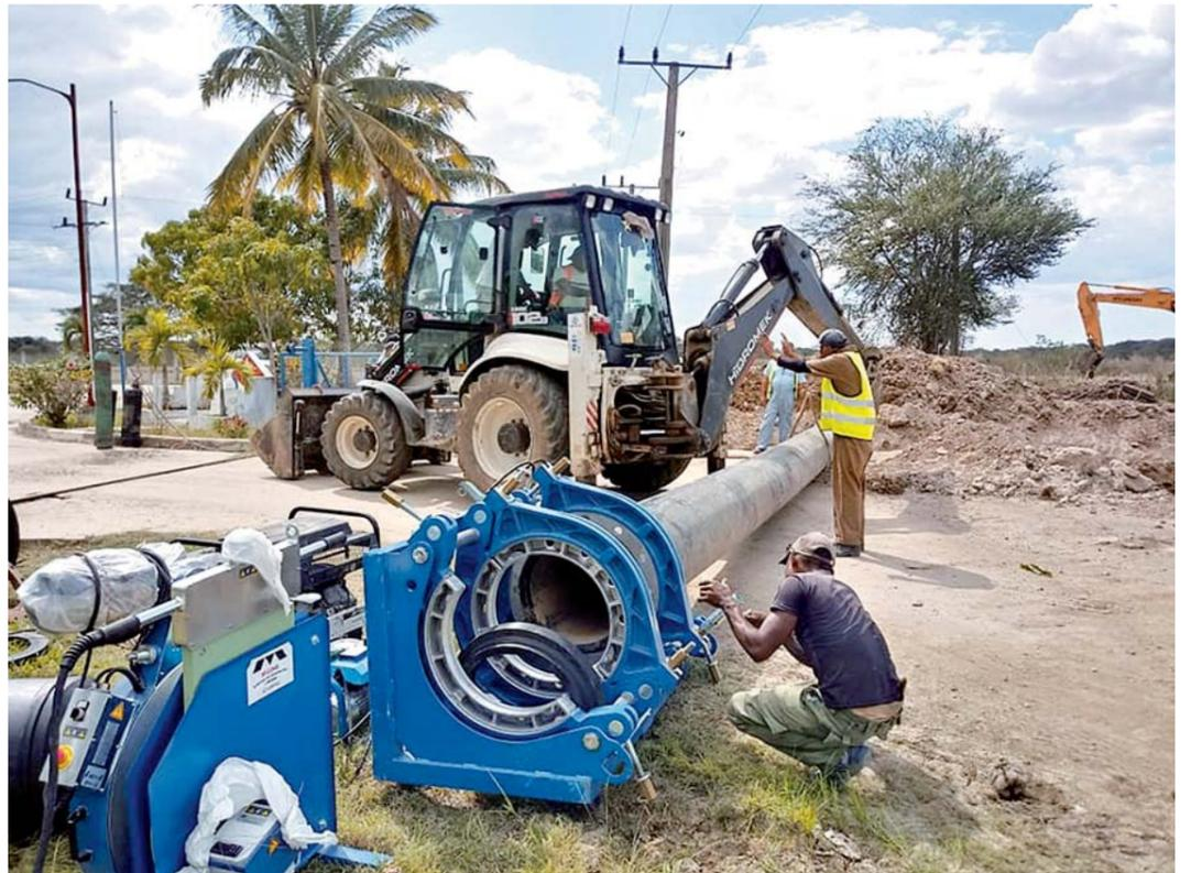
**Inicio de trabajos de conexión de conductora de la planta potabilizadora de Santa Isabel, en Bayamo, con el tanque apoyado de Barrio Azul, para realizar pruebas de desinfección y estanqueidad en ambas obras**
