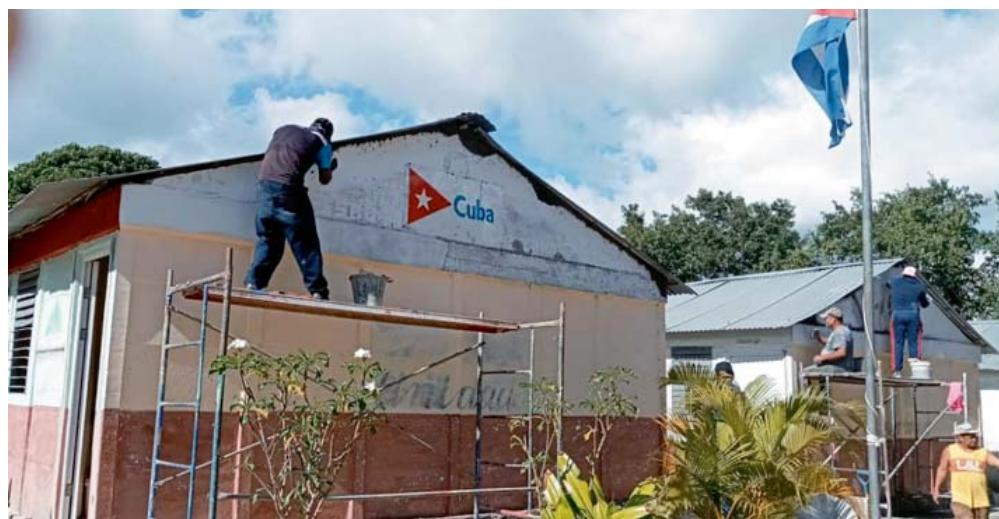
En proceso de reparación se encuentra la Esbu Ignacio Pérez Zamora
